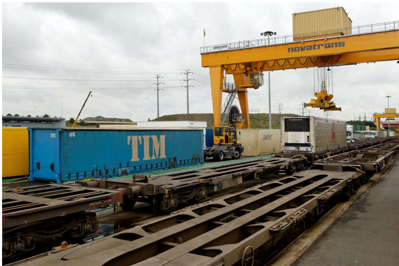
Plateforme multimodale de transport rail-route de Valenton (94) ©L. Mignaux/Terra
